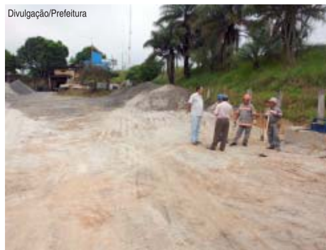
A obra do Corpo de Bombeiros na MG-050 já começou, mas o prefeito quer agilizar a unidade
