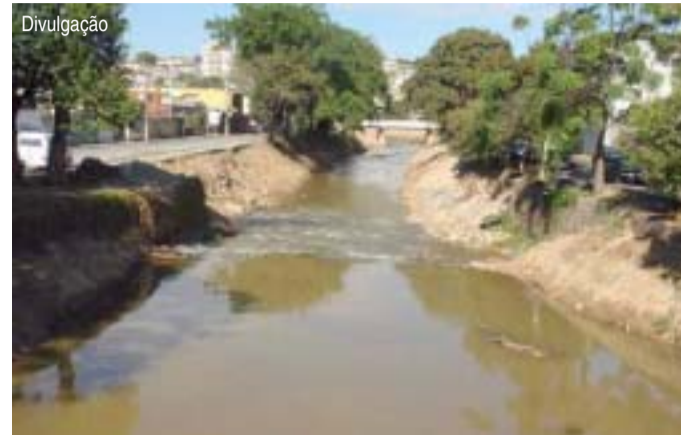
As obras serão feitas na margem esquerda do rio Formiga, além do rio Mata Cavallo e córregos
